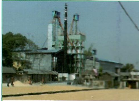
বিখাস ট্রেডার্স এন্ড ভিআইপি অটো রাইস মিল, আইলতার বাজার, শেখারাব, কুষ্টিয়া। প্রতিদিন ৯৬ টন কমতাসম্পন্ন পারবয়েলিং, ড্রায়ার, ৮ টন মিলিং ও ৫ টন বয়লার।
