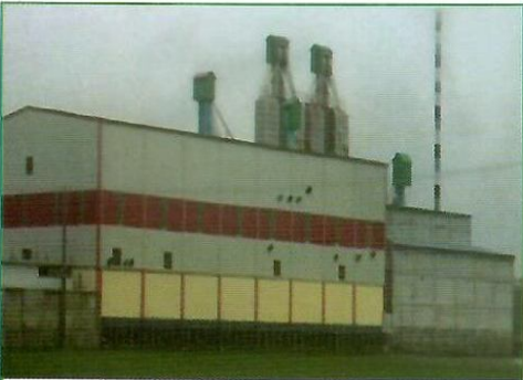
জে এন্ড এস ফুড এন্ড বেভারেজ লিমি, ঢাকলহাটি, শেরপুর। প্রতিদিন ৩২০ টন কমতাসম্পন্ন পারবয়েলিং, ড্রায়ার ও ১০ টন বয়লার।
