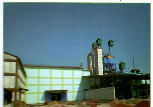
শকিল অটো রাইস মিল, বাগুড়াহাট, ময়মনসিংহ। প্রতিদিন ৯৬ টন কমতাসম্পন্ন পারবয়েলিং, ড্রায়ার, ৫ টন বয়লার এবং ৮ টন মিলিং।
